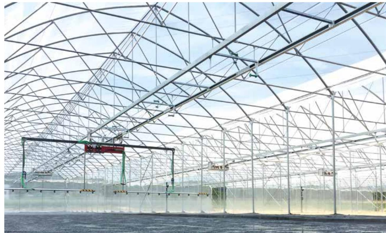
Le barre Idrojet EVO 2.0 DB sono macchine per irrigazione con sistema di sospensione tubo a ricircolo, la tubazione dell'acqua e i cavi di alimentazione "riciccolano" sulle staffe aeree senza creare intralcio a cose o persone in serra. Lo scorrimento della macchina avviene su doppia rotaia, che ne garantisce la stabilità. Il satellite di ricircolo è mosso in maniera sincrona tramite dei rinvii a cavo.
