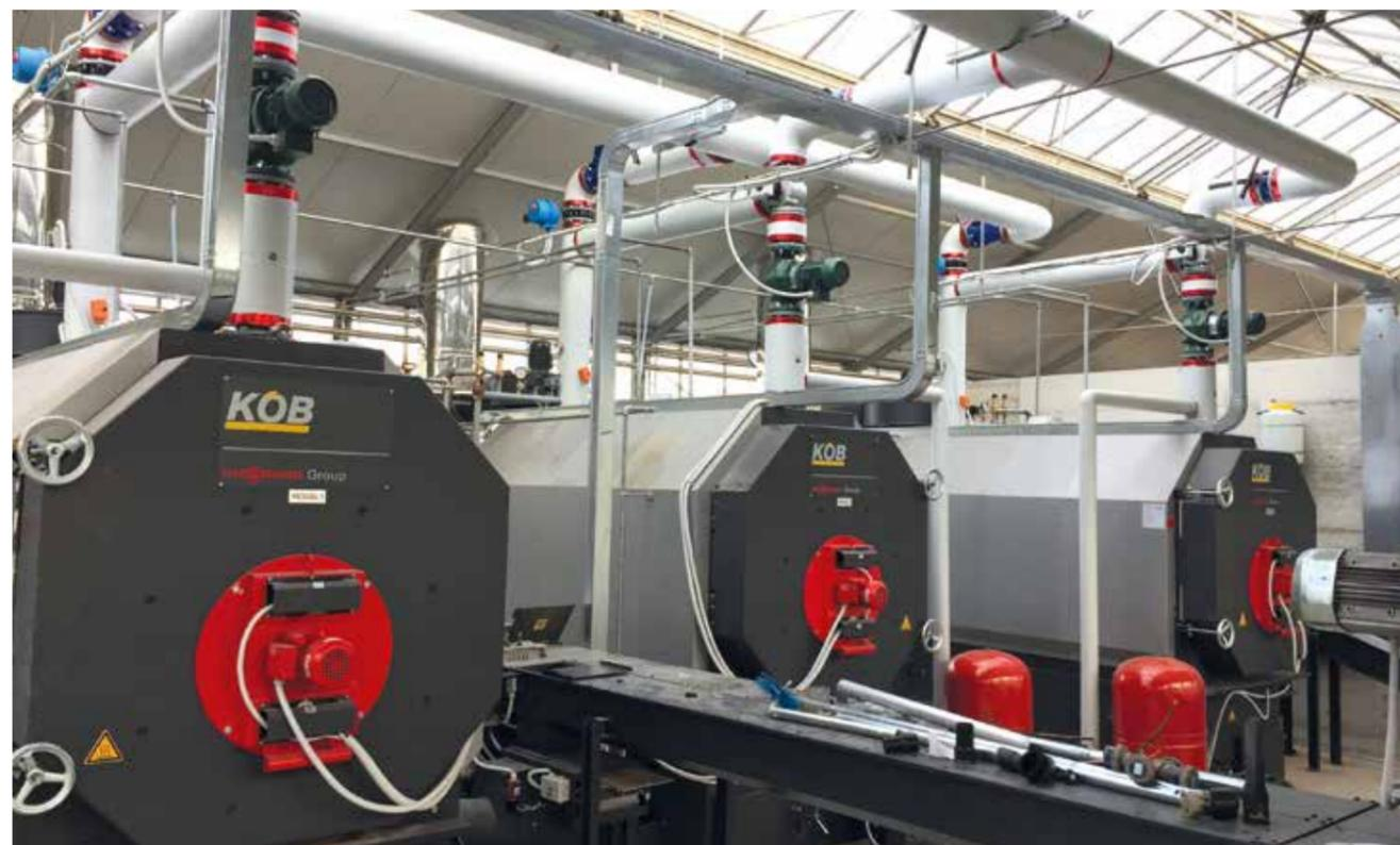
Idroterm progetta e installa centrali termiche a servizio delle serre sia con combustibili tradizionali come gasolio e metano (anche a condensazione), che con combustibili a biomassa come cippato e pellet, in abbinamento a serbatoi inerziali
