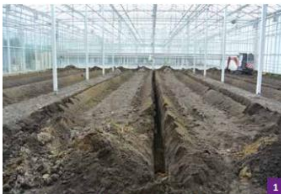
Aanleg stoomdrainage door L. Christiaens. De zuigdrains zijn om de 2,67 meter ingegraven. Op het einde gaat de hoofddrain naar buiten en mondt uit in de pompput.
