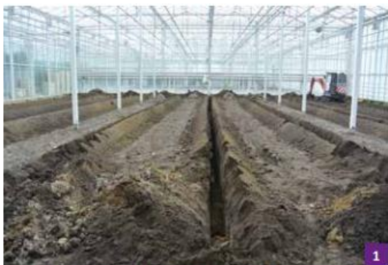
1 Aanleg stoomdrainage door L. Christianen. De zuigdrains zijn om de 2,67 meter ingegraven. Op het einde gaat de hoofddrain naar buiten en mondt uit in de pompput.
